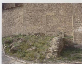
Pared de la iglesia que pudo corresponder a una parte de la fortaleza. Se aprecia una puerta tapiada y un arranque de un muro que pudo pertenecer al viejo castillo. (Fotografía y estudio cedido amablemente por Pascual Plano, vecino de Lobera de Onsella.)
